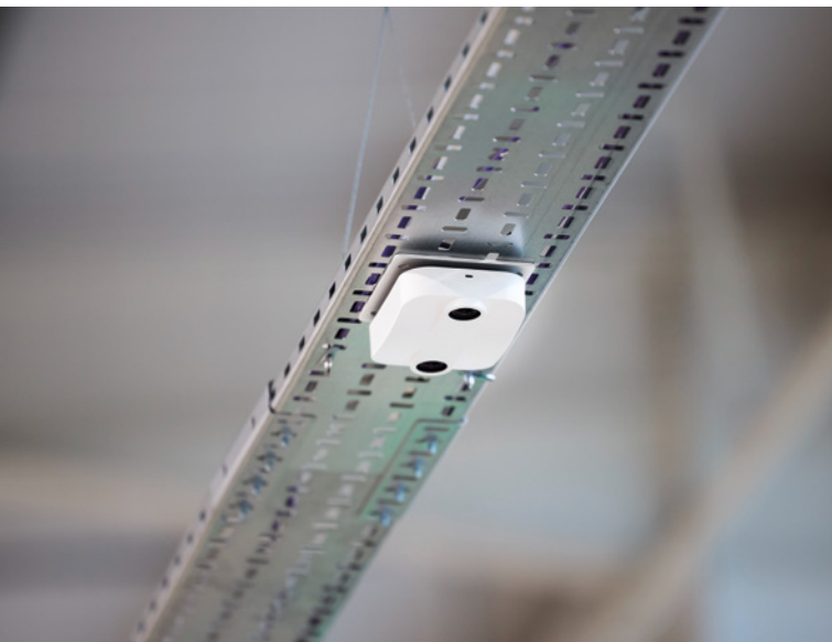
3D-Sensoren an der Decke erfassen Laufwege, Verweildauern und Wartezeiten am Checkout
